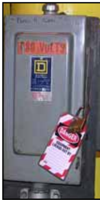
Figura 6-2: Bloqueo/Etiquetado del panel de fuente de alimentación
